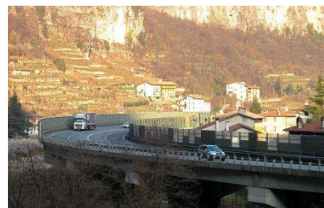
L'attuale viadotto che attraversa la frazione di San Marino
