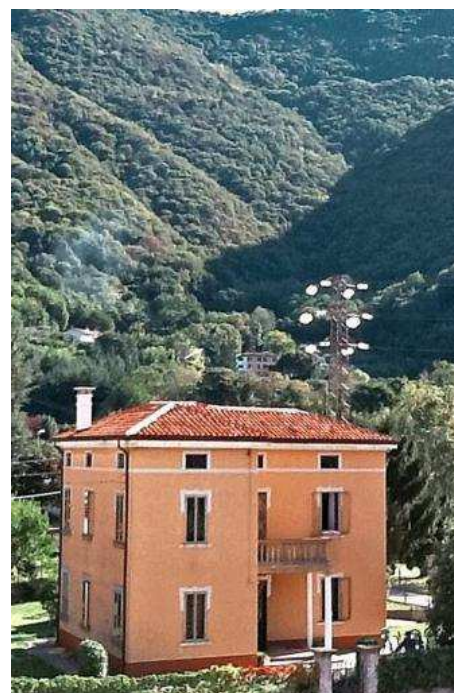
La Val Nogarole, dove dovrebbero sorgere i viadotti
